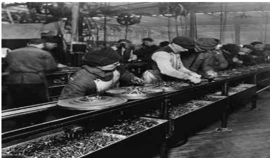
Εικ.1 Γραμμή συναρμολόγησης Ford. Πηγή: https://walk2geographies.wordpress.com/2011/06/20/fordisme-fordism/
