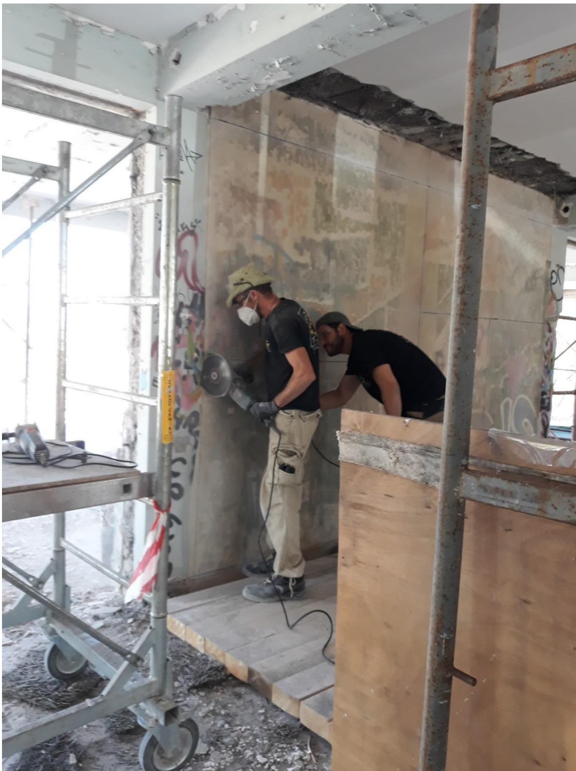
Εικόνα 7. Διαδικασία αποτοίχισης της νωπογραφίας του Νίκου Νικολάου στο Ξενία Σπάρτης 2021, φωτογραφία: Κάριν Βελίκα
