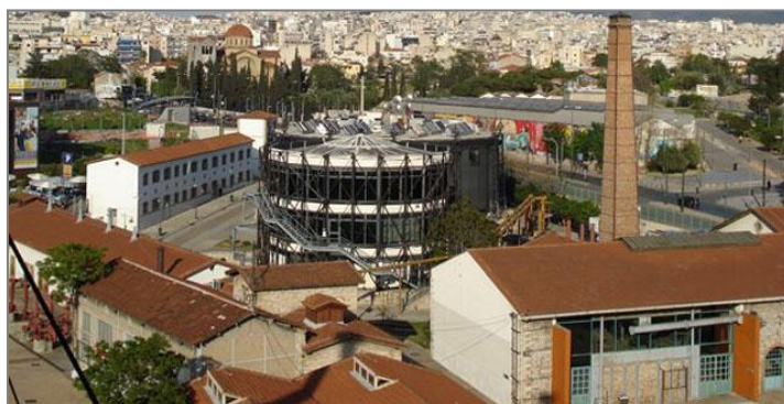
Εικόνα 5.1. Αποψη Βιομηχανικού Μουσείου Φωταερίου, http://www.technopolis-athens.com/web/guest/visitors/gasmuseum
