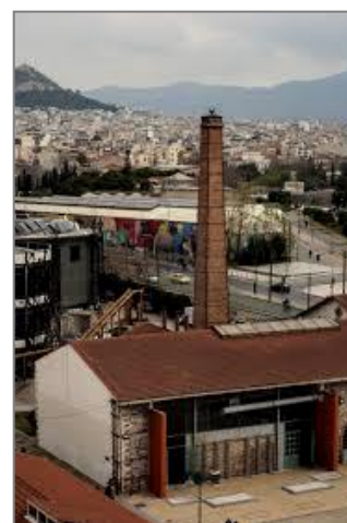
Εικόνα 5.4.Εξωτερική άποψη του κτηρίου Παλαιών Φούρνων
