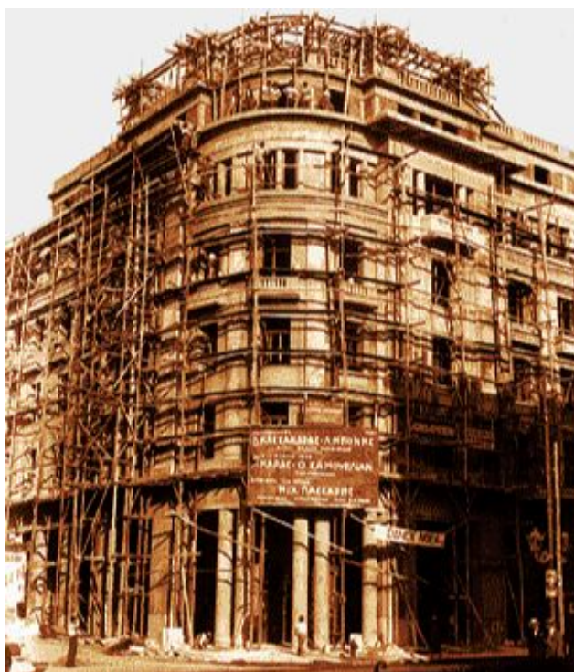
Το ΜΤΣ στη φάση ανοικοδόμησης του κτιρίου της Σταδίου
