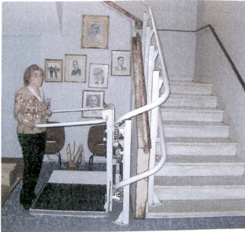
Εικόνα 24. Ο ανελκυστήρας κλίμακας που συνδέει το ισόγειο με τον Α' όροφο
