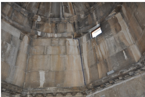
Εικόνες 62, 63. Εγκατάσταση συστήματος ενόργανης παρακολούθησης.
