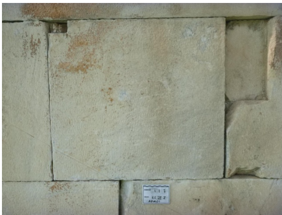
Εικόνες 60, 61. Ανατολική όψη, Αντικατάσταση κονιαμάτων στους αρμούς.
