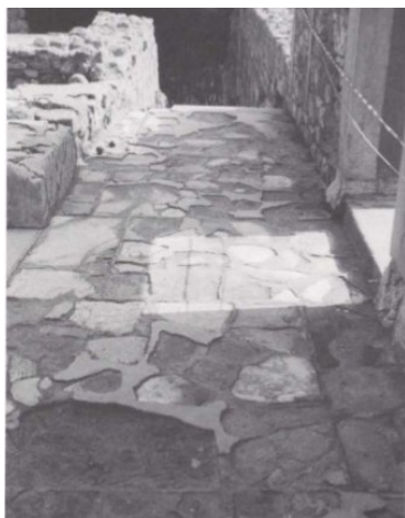
Εικόνα 10. Κνωσός. Ανατολικό - Δυτικός διάδρομος (1994). Το τσιμέντο που χρησιμοποιήθηκε το 1928 διατηρείται καλύτερα από το αυθεντικό υλικό της οδόστρωσης.
