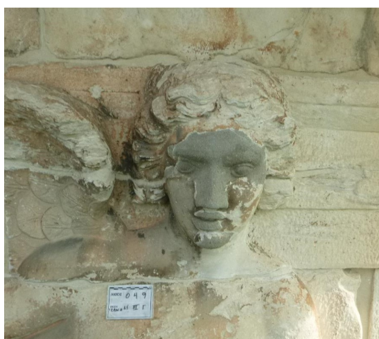
Εικόνα 55. Ζέφυρος, Δ όψη. Παλαιότερη συμπλήρωση.
