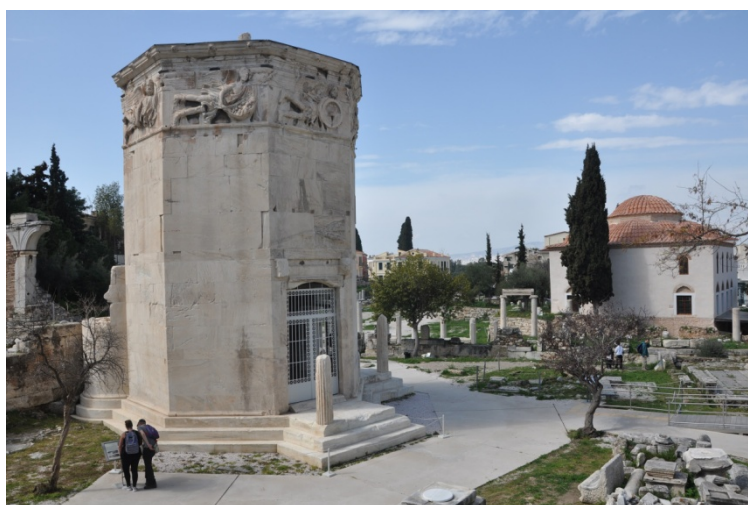
Εικόνα 74. Άποψη του μνημείου μετά την ολοκλήρωση των εργασιών. Διακρίνεται η ενημερωτική πινακίδα για το εσωτερικό του μνημείου.
