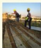
Στέγαστρο των επιφανειών των λίθων με μεταλλικούς ακροτήριους υδρορροές του αερίσμου στη στέγη Maintenance work on the attachment surfaces of the stone by installing drainage of calcium hydroxide on the roof
