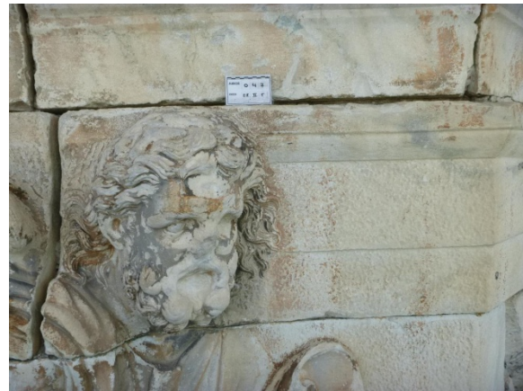
Εικόνες 57, 58, 59. Σκίρων, ΒΔ όψη. Αντικατάσταση κονιαμάτων στους αρμούς.
