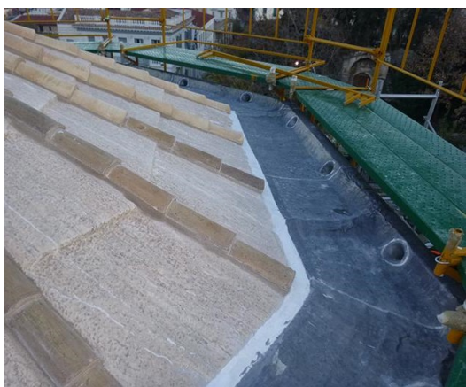
Εικ. 69, 70. Εφαρμογή φύλλων μολύβδου στη στέγη και στις λεοντοκεφαλές για την αποκατάσταση της απορροής των ομβρίων υδάτων.
