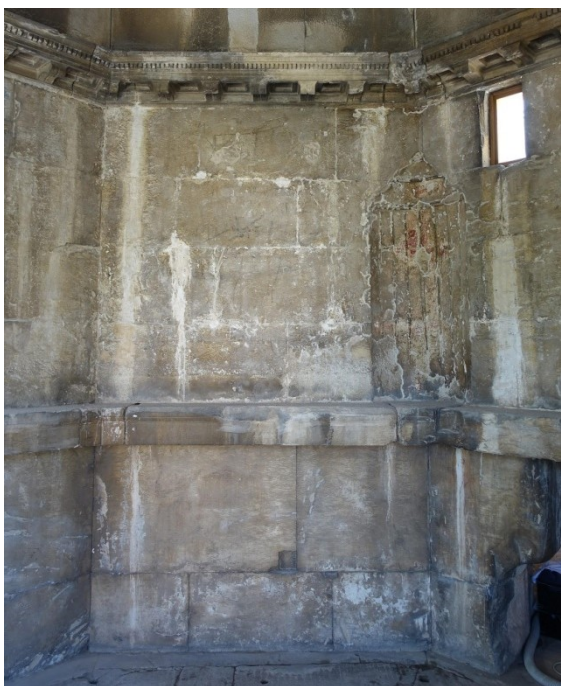
Εικόνα 22. ΝΑ όψη εσωτερικά, πριν τις τελευταίες επεμβάσεις.
