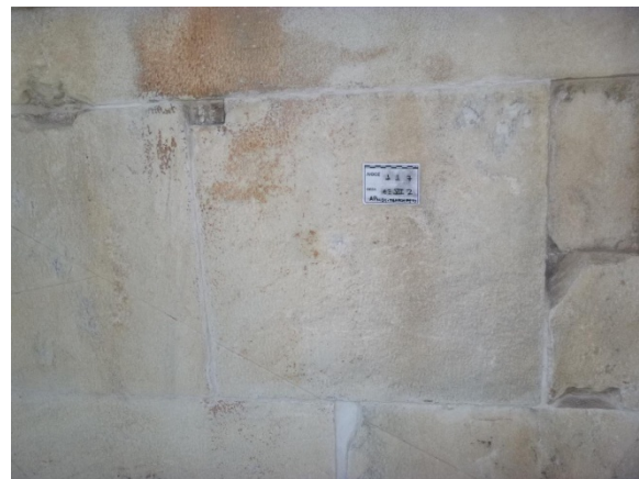
Εικόνες 60, 61. Ανατολική όψη, Αντικατάσταση κονιαμάτων στους αρμούς.
