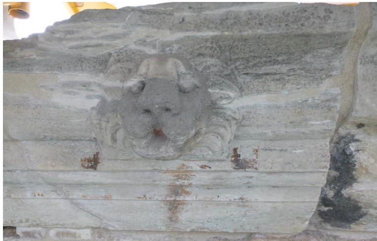
Εικόνα 53. Λίθος 27, Βόρεια όψη. Διατήρηση συμπλήρωσης σε λεοντοκεφαλή.
