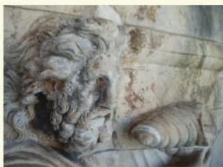
Αποκόλληση και εργασία συντήρησης τημνίου στο ανάγλυφο του ΒΟΡΕΑ Bonding of fragment of the representation of the NORTH wind on the frieze
