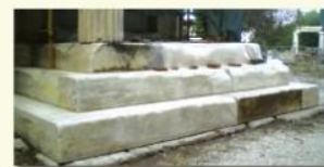
Καθαρισμός της κρηπίδας από τις έντονες βιολογικές επιβιώσεις. Αποκρίνεται τμήμα της αρχικής κατάστασης την των κατασκευών In the course of cleaning the organic deposits on the crepidoma (step) of the monument
