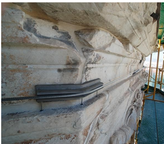
Εικόνες 67, 68. Εφαρμογή εξωτερικής περίδεσης του μνημείου.
