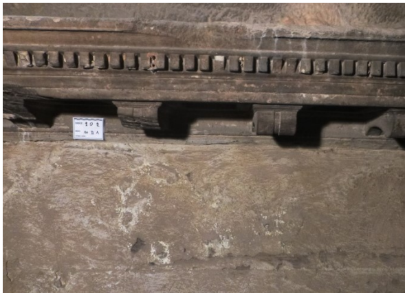
Εικόνα 37. Λίθος 202, ΒΔ όψη, εσωτερικά. Πριν τις επεμβάσεις.
