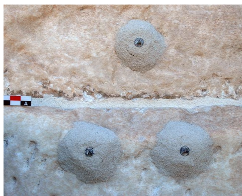
Εικόνες 62, 63. Εγκατάσταση συστήματος ενόργανης παρακολούθησης.
