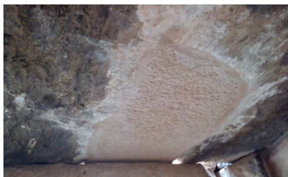
Εικόνες 45, 46. Πρόσκτισμα εσωτερικά. Αντικατάσταση αποσαθρωμένης συμπλήρωσης.
