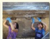
Διενέργεια του κοινού γέφυρου στο εσωτερικό του μνημείου Conservation of the ionic cornice inside the monument
