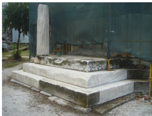
Εικόνα 42. Στάδιο καθαρισμού ΒΑ κρηπίδας.
