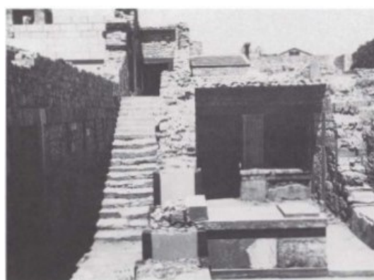
Εικόνα 5. Κνωσός. Άποψη του χώρου μετά την ανακατασκευή (1928).
