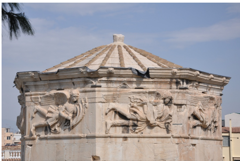
Εικόνες 71, 72. Απόψεις του μνημείου από το έδαφος. Διακρίνεται η περίδεση και τα φύλλα μολύβδου στη στέγη.
