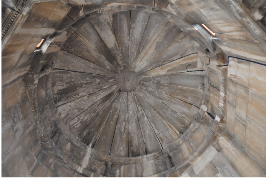
Εικόνα. 31. Αποψη της στέγης εσωτερικά μετά τις τελευταίες επεμβάσεις.
