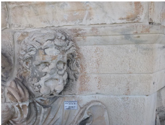
Εικόνες 57, 58, 59. Σκίρων, ΒΔ όψη. Αντικατάσταση κονιαμάτων στους αρμούς.
