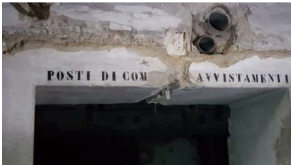
Εικόνα 16 – Εσωτερικό κέντρου ασυρμάτου, όρος Πατέλα
