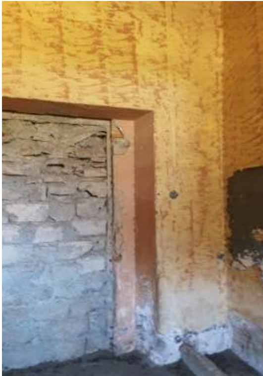
Εικόνα 19 – Εσωτερικό κτιρίου στρατωνισμού, όρος Πατέλα
