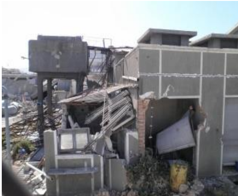
Εικόνα 18: Η κατεδάφιση του αρχικού πυρήνα του συγκροτήματος Μουζάκη (Κουφόπουλος, 2016).
