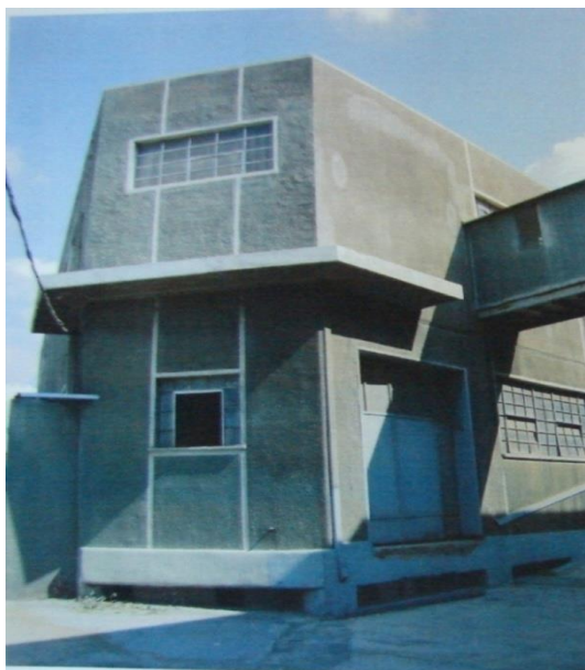
Εικόνα 16: Απεικόνιση της συνδετήριας γέφυρας. Φωτογραφικό υλικό που συνόδευε την Αίτηση Κατεδάφισης (Πηγή: ΔΤΕ).
