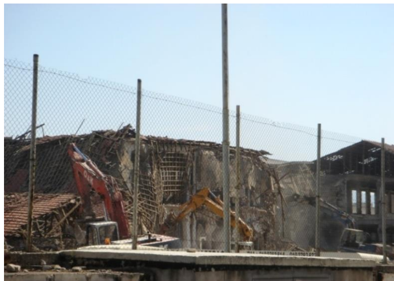
Εικόνα 19: Στιγμιότυπο της κατεδάφισης του Συγκροτήματος Μουζάκη από τη ΜΟnuMENTA, η οποία ενημέρωσε την τότε Εφορεία Νεωτέρων Μνημείων, φορέα που βάσει του νόμου 3028/02 θα έπρεπε να έχει ενημερωθεί και γνωμοδοτήσει (Γρατσία, 2011).
