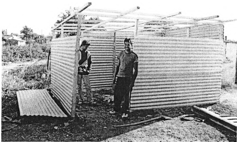
Κατασκευή υαθαίρετου στην Αδριανονπόλεις ( Οκτώβριος 2003)
