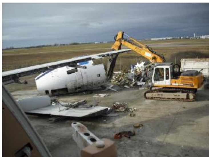
Εικόνα 13: Η διάσπαση του αεροσκάφους με γερανό διάτμησης 241
