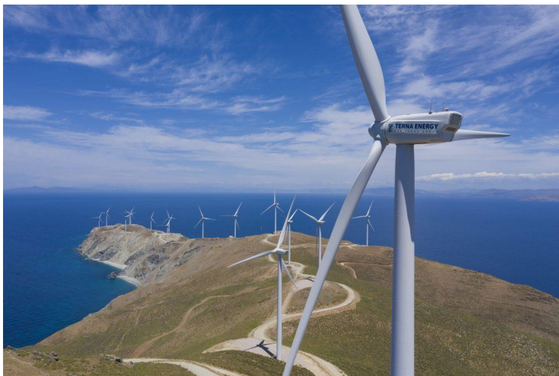
Εικόνα 3.3: Αιολικό Πάρκο στην νησίδα του Αγίου Γεωργίου ανάμεσα στον Σαρωνικό Κόλπο και τις Δυτικές Κυκλάδες. Αποτελείται από 23 ανεμογεννήτριες συνολικής ισχύος 73,2 MW και η ενέργεια μεταφέρεται μέσω υποθαλάσσιου καλωδίου στην Αττική. (Πηγή: ΤΕΡΝΑ ΕΝΕΡΓΕΙΑΚΗ)
