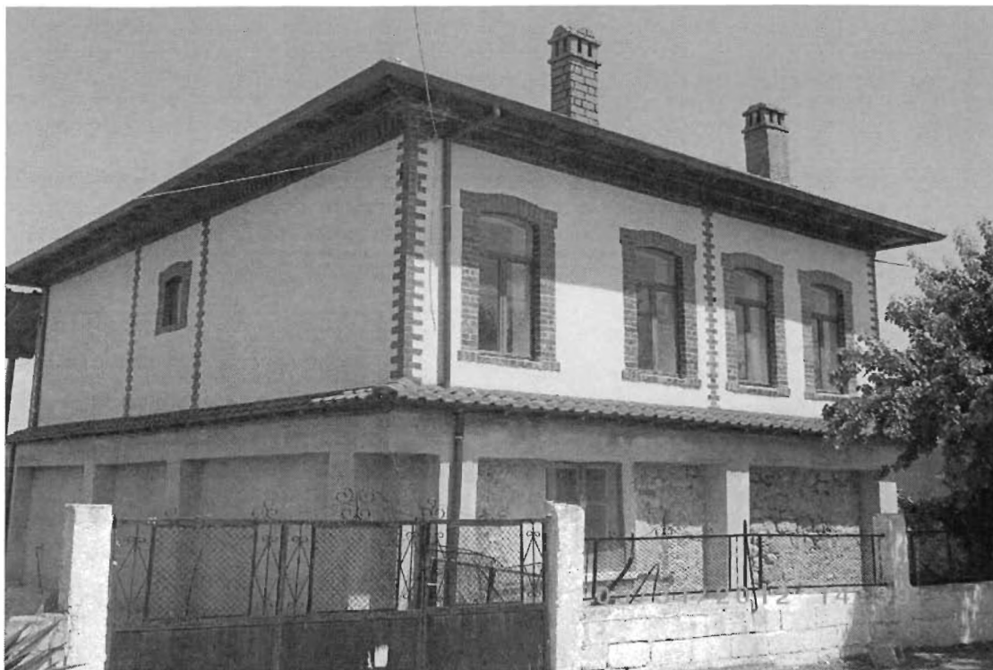
Οικία Κρουσταλλόπουλου (ντόπιου) κτισμένη το 1918 (Το 2011 έγινε ανακαίνιση του επάνω ορόφου)
